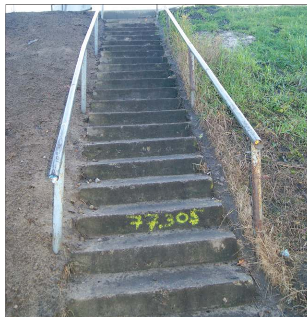
Stare, wysłużone schody zostaną wkrótce zastąpione nowymi
