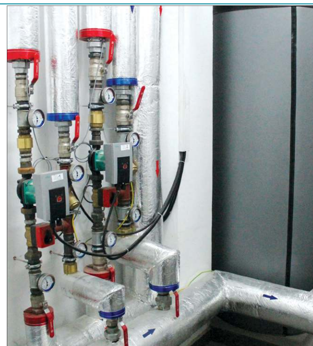
Kompleksowo przebudowana została sieć centralnego ogrzewania
