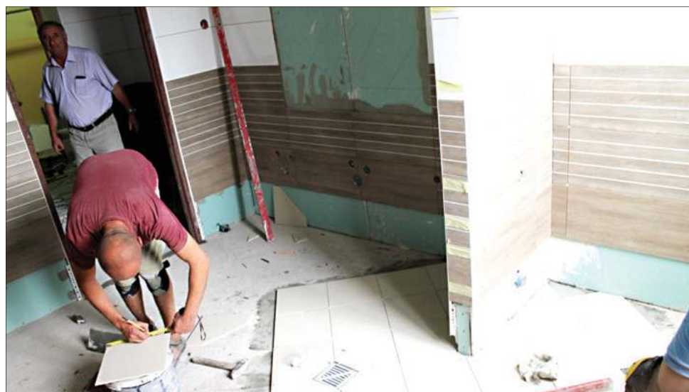
Gruntowy remont przechodzą trzy sanitariaty w SP 3
