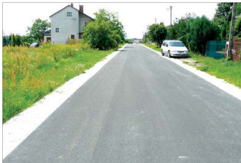
Ulica Równoległa na Malesinie zyskała szeroką, równą nawierzchnię
