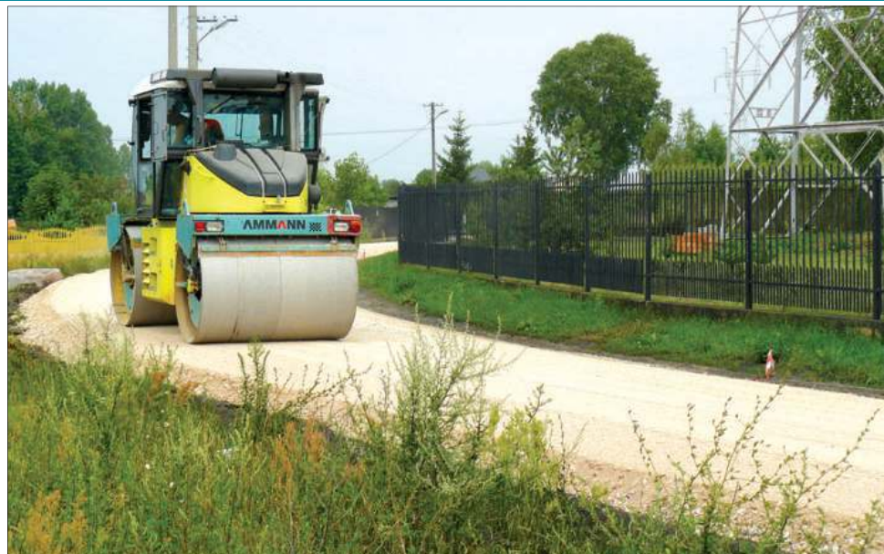
Prace na ulicy Kwiatów Polnych
