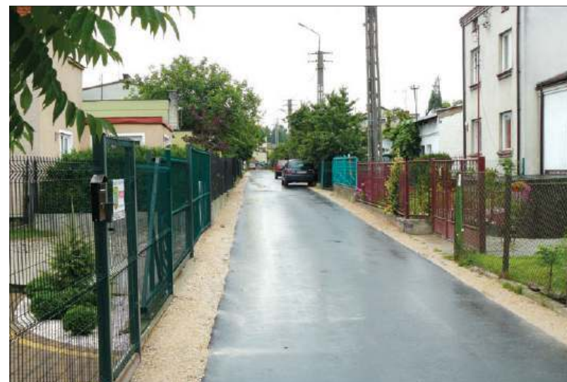
Nowy asfalt na ulicy H. Sucharskiego
