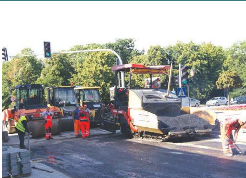
Do remontu powiatowej ulicy Staszica miasto dołożyło ponad 1,8 mln. zł
