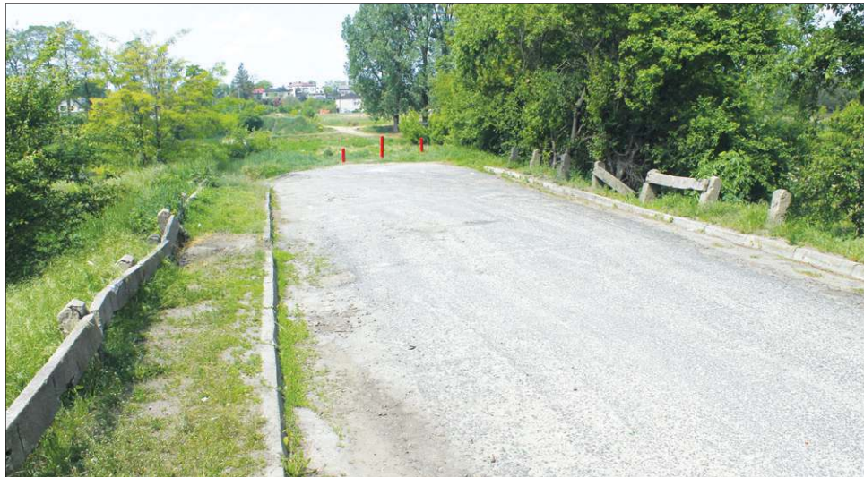
Tak obecnie wyglądają przyczółki starego mostu przy ul. Toruńskiej
