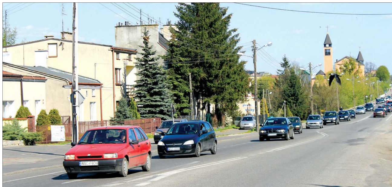
Na moście będzie ścieżka rowerowa, nowe chodniki i stylizowane oświetlenie
