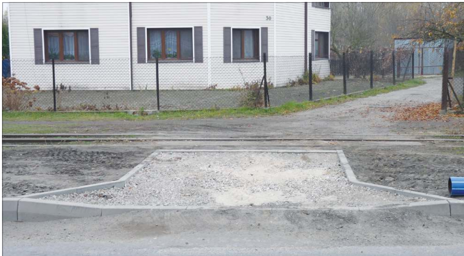
Wjazd od ulicy Wyszogrodzkiej, który kieruje prosto na siatkę ogrodzeniową
