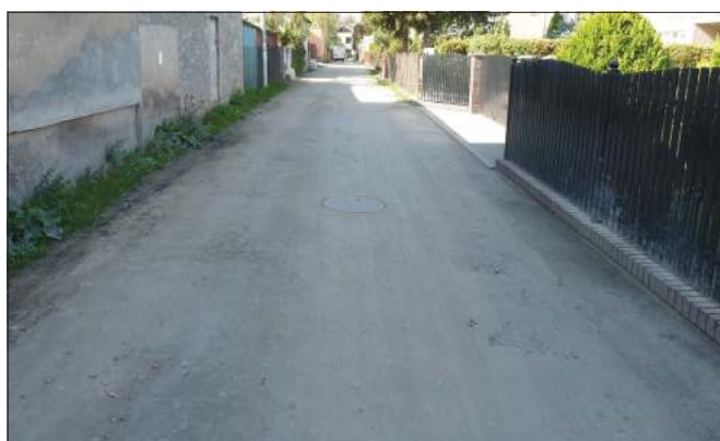
Szereg ulic, tak jak Mieszka I, jest już wyremontowana i czeka tylko na nakładkę asfaltową
