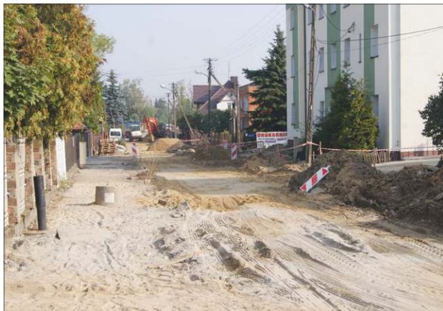
W połowie października będzie tu nowy asfalt
