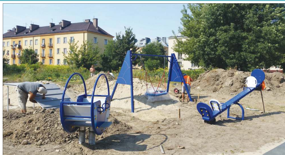
Prace przebiegają bardzo sprawnie. Już niedługo na ogródek wbiegną dzieci
