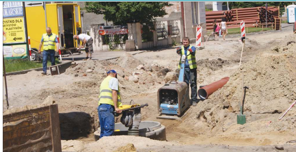
Na plac budowy weszli wykonawcy od oświetlenia i kanalizacji
