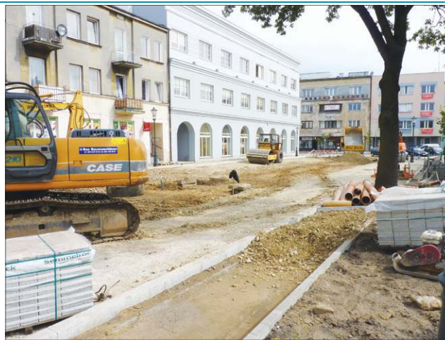
Podczas remontu placu Obrońców Sochaczewa pod ziemią umieszczono instalacje niezbędne do zamontowania parkomatów
