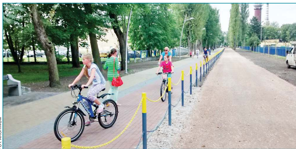
Jedną z ważnych ubiegłorocznych inwestycji była przebudowa Pasażu Duplickiego
