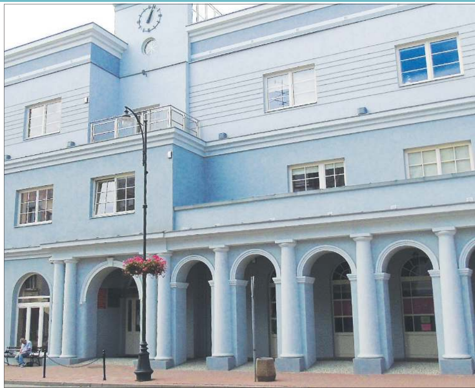
Wyłoniony został wykonawca remontu tarasu zabytkowych kramnic miejskich
