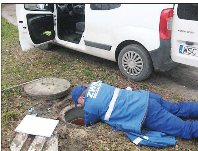
Jedna z kontroli studzienek kanalizacyjnych
