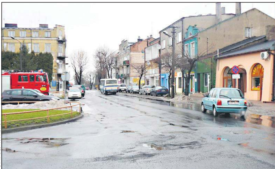
W pierwszej kolejności remont obejmie fragment Staszica od Warszawskiej do Toruńskiej
