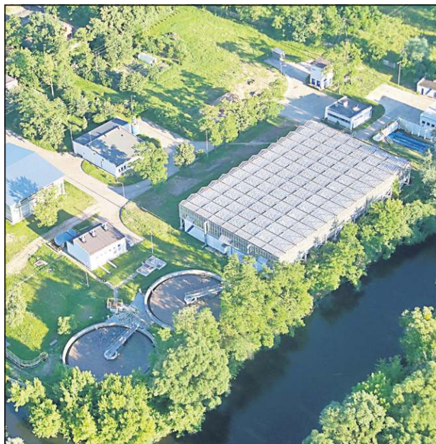
W ramach projektu kanalizacyjnego zmodernizowano oczyszczalnię ścieków
