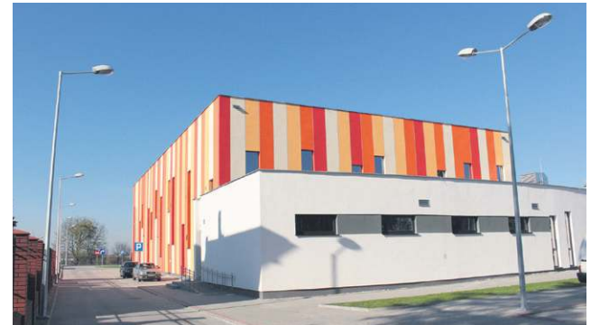
Hala przy SP 4 zostanie oddana do użytku 5 listopada
