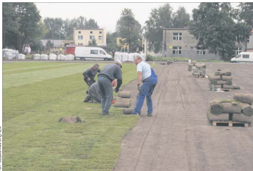
Ekipa odpowiedzialna za ułożenie trawy przy pracy
