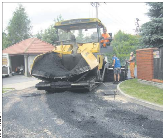
Ciężki sprzęt pracujący na ul. Modrzewiowej
