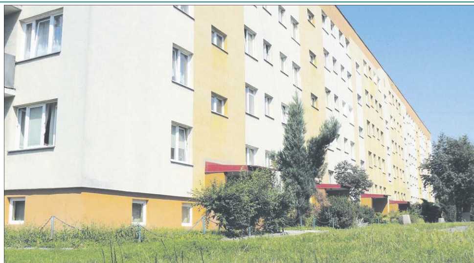
Mieszkańcy tego bloku nie zdawali sobie sprawy, z jakim zagrożeniem mają do czynienia
