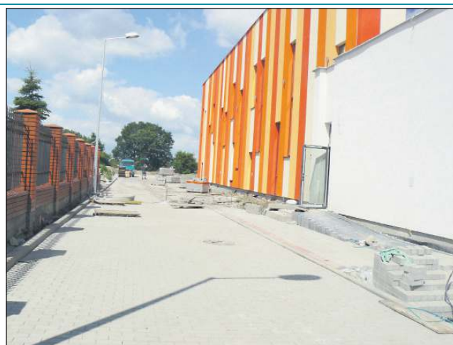
Na zewnątrz ułożono już kostkę brukową
