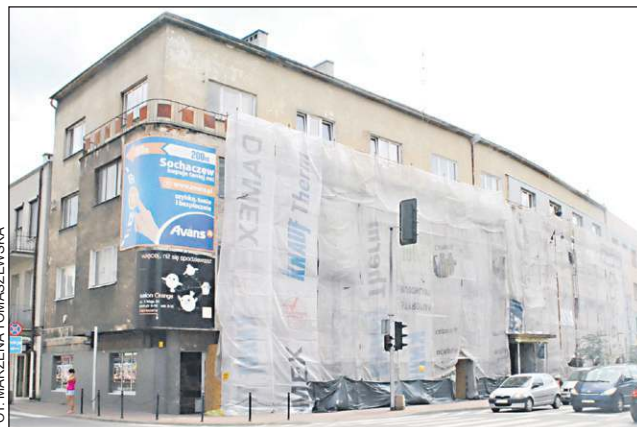
Kilka dni temu rozpoczął się remont elewacji kamienicy Kobka
