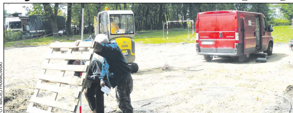
Zerwano już nawierzchnię asfaltową. Niedługo staną nowe latarnie
