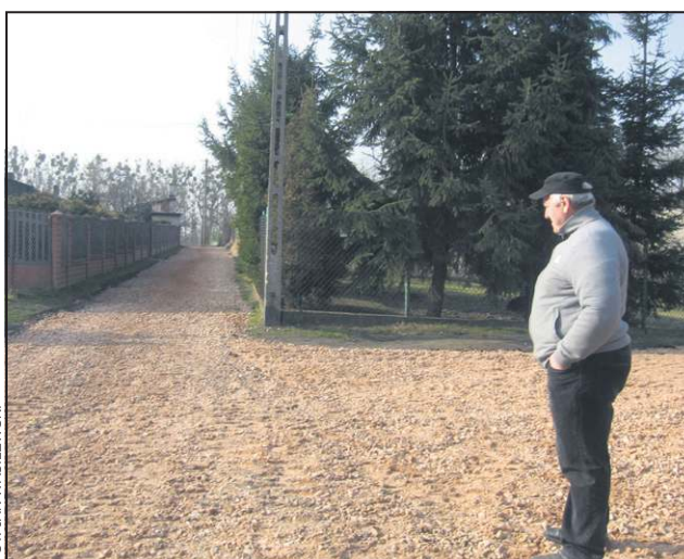
Po zakończeniu prac ulica wygląda jak nowa
