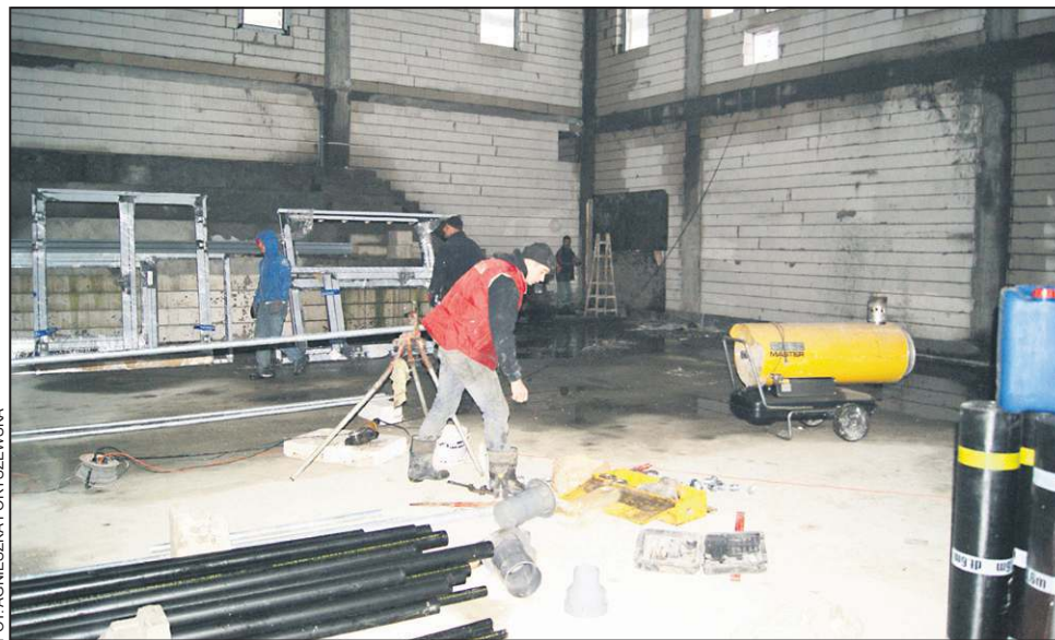
Prace w nowej hali przebiegają terminowo. Nie opóźniły ich nawet ostatnie mrozy
