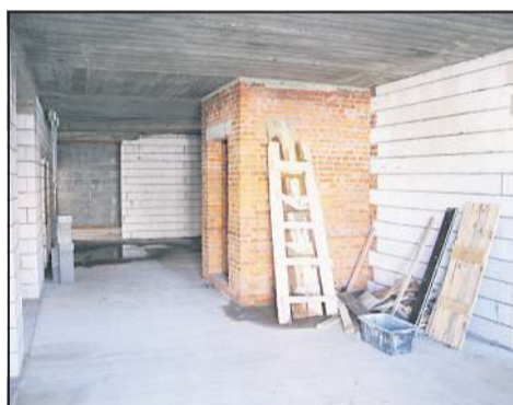
Jesienią 2012 stoją ściany, wylany jest strop nad górną konygnacją, zaczynają się prace w środku
