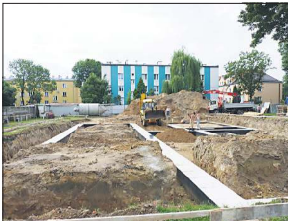
Sierpień 2012 - fundamenty gotowe
