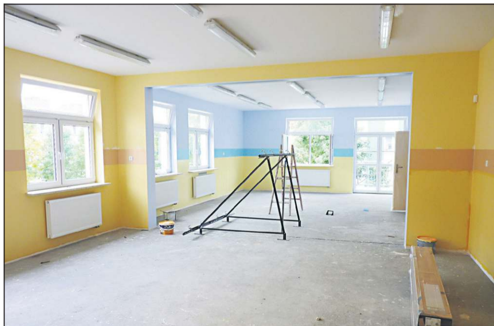
Wiosna-lato-jesień 2013 - roboty wykończeniowe wewnątrz i na zewnątrz żłobka
