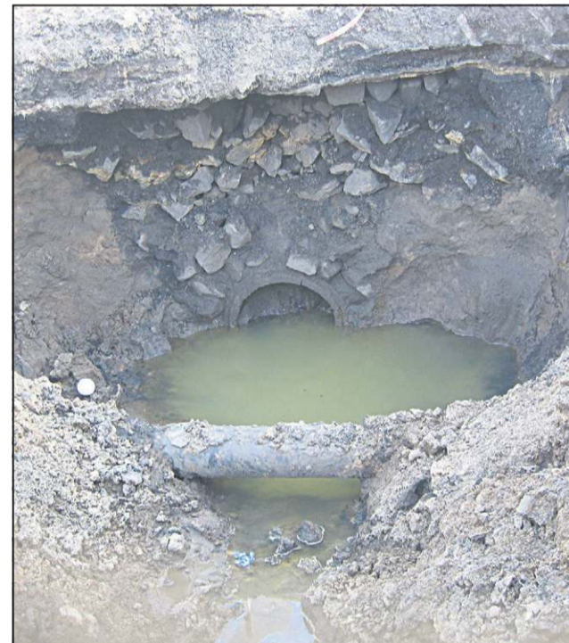
Tak wygląda odkryty przez koparkę przepust pod ulicą
