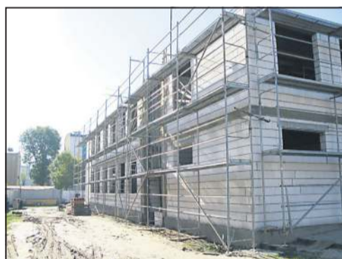
Jesienią 2012 stoją ściany, wylany jest strop nad górną konygnacją, zaczynają się prace w środku
