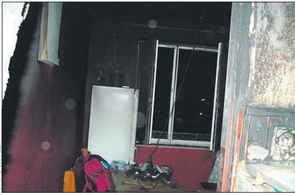
Remont mieszkania przeprowadzi Zakład Gospodarki Mieszkaniowej
