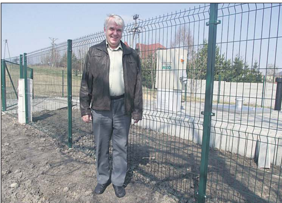
Prezes Stanisław Grażka przy wykonanej w ramach projektu tłoczni nr 1 przy ul. Gawłowskiej
