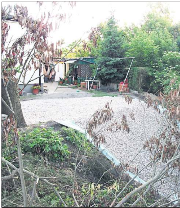
Skarpę przy ul. Wyszogrodzkiej bardzo szybko naprawiono
