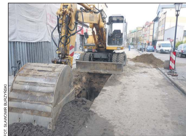
Remontowi towarzyszy wymiana podziemnych instalacji
