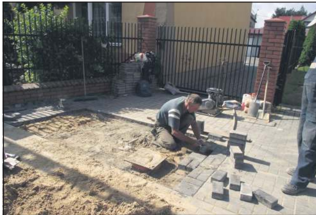
Pogoda sprzyja budowaniu przyłączy
