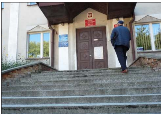
Brak dostosowania wejść dla osób niepełnosprawnych to jeden z problemów, który może rozwiązać budżet obywatelski
