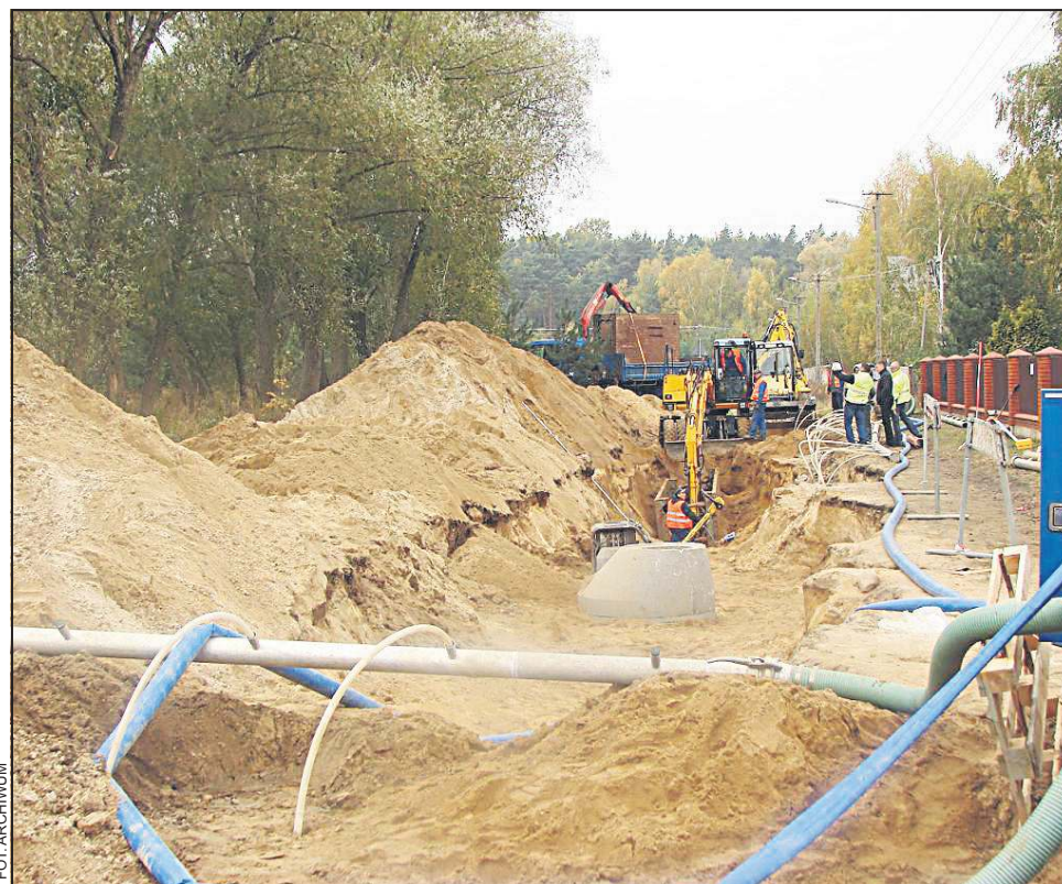
Przez rok trwały prace przy kanalizacji miasta, teraz nadszedł czas na przyłącza
