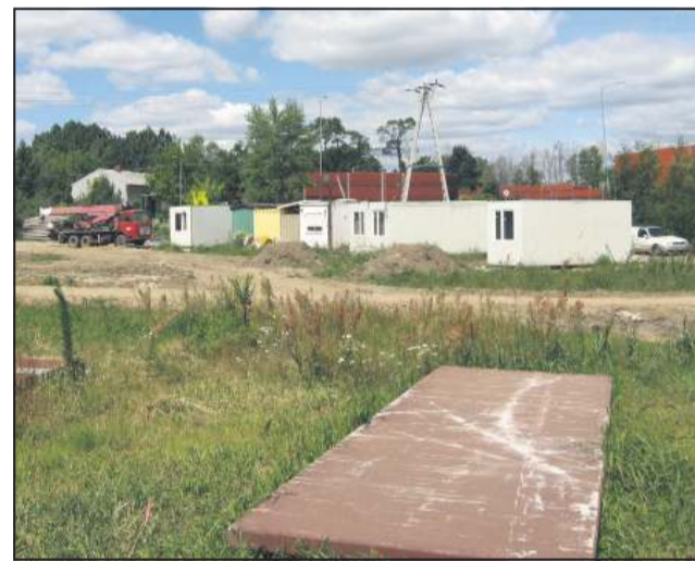
Zakończył się montaż ekranów dźwiękoszczelnych na obwodnicy
