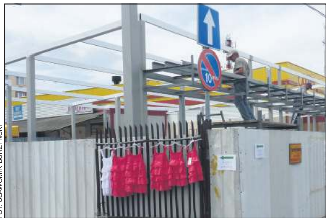
Jak widać budowa nie przeszkadza w handlu
