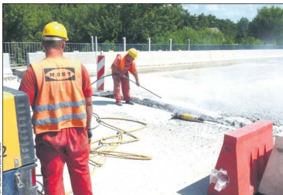
Na wiadukcie przygotowywane jest podłoże pod nawierzchnię asfaltową
