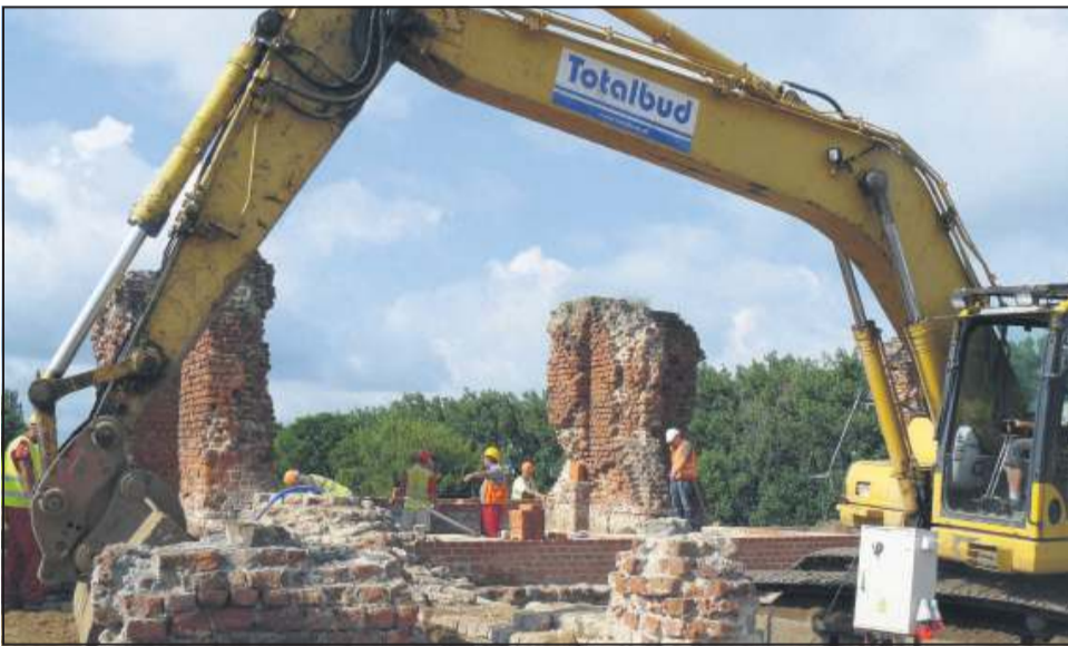
Firma Skanska zabezpiecza istniejące ściany zamku
