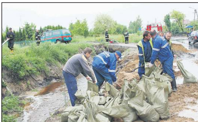
Przy usuwaniu skutków ulewy pracowała cała załoga ZGM
