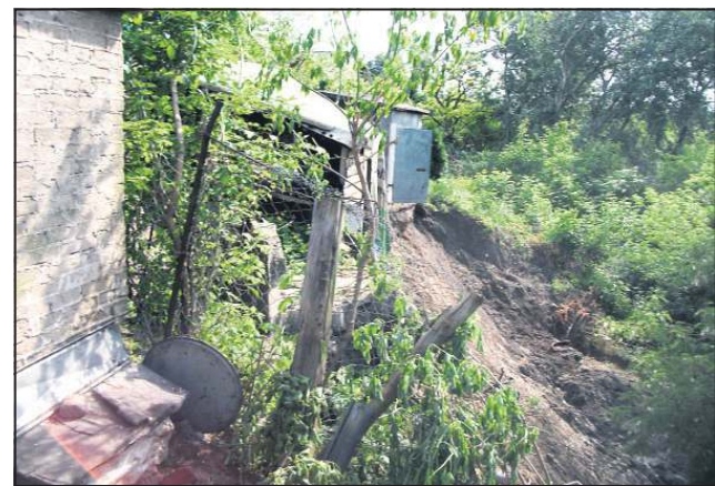
Osuwisko przy ulicy Kolejowej
