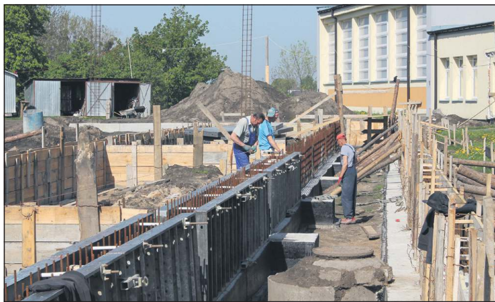
Prace przy budowie sali idą pełną parą
