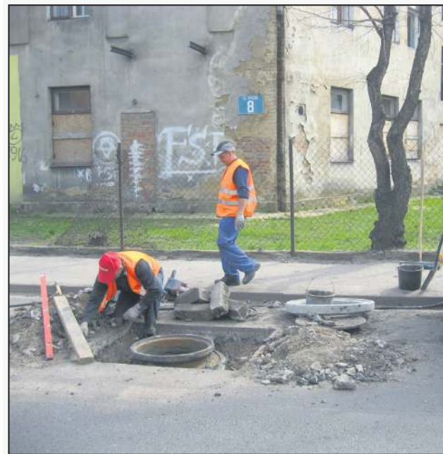
Ekipa remontuje studnie przy ul. Okrzei
