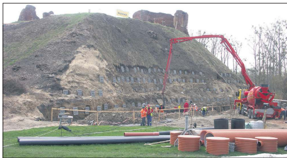
Firma Skanska zabezpiecza zarówno wzgórze zamkowe jak i mury warowni
