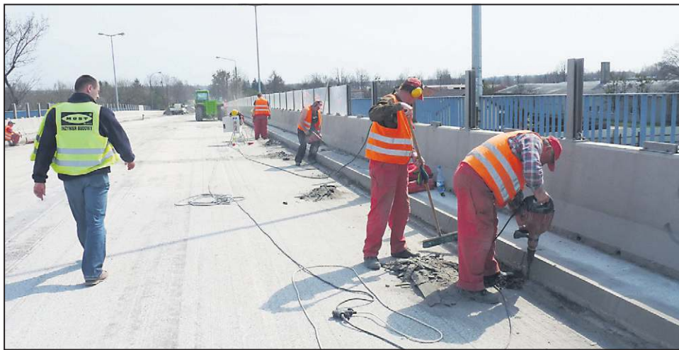
Zrywanie starej nawierzchni dobiega końca
