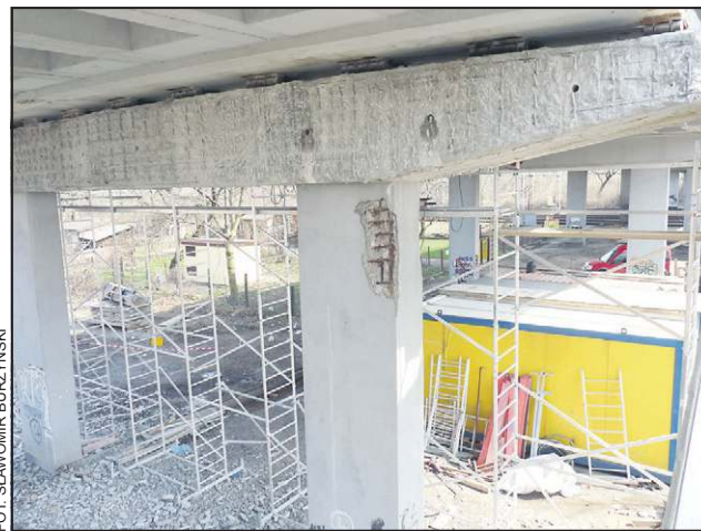
Rdzewiejące filary zostaną wyremontowane i wzmocnione
