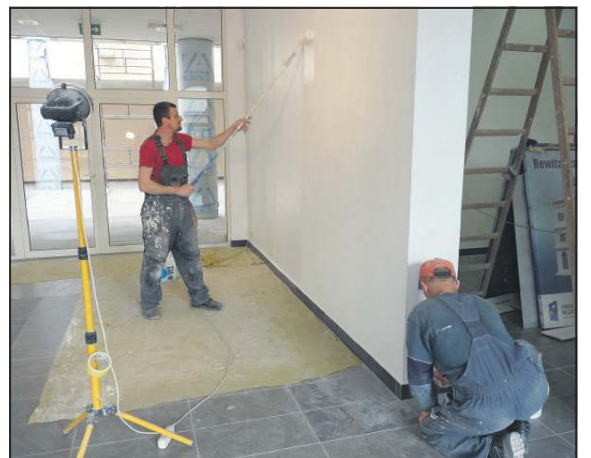
Robotnicy kładą ostatnie warstwy farby
