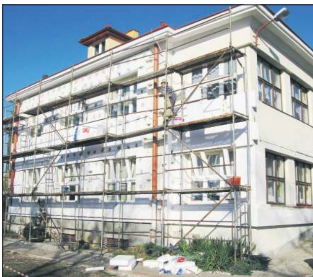
Ocieplenie ścian to jeden z elementów inwestycji w Chodakowie
