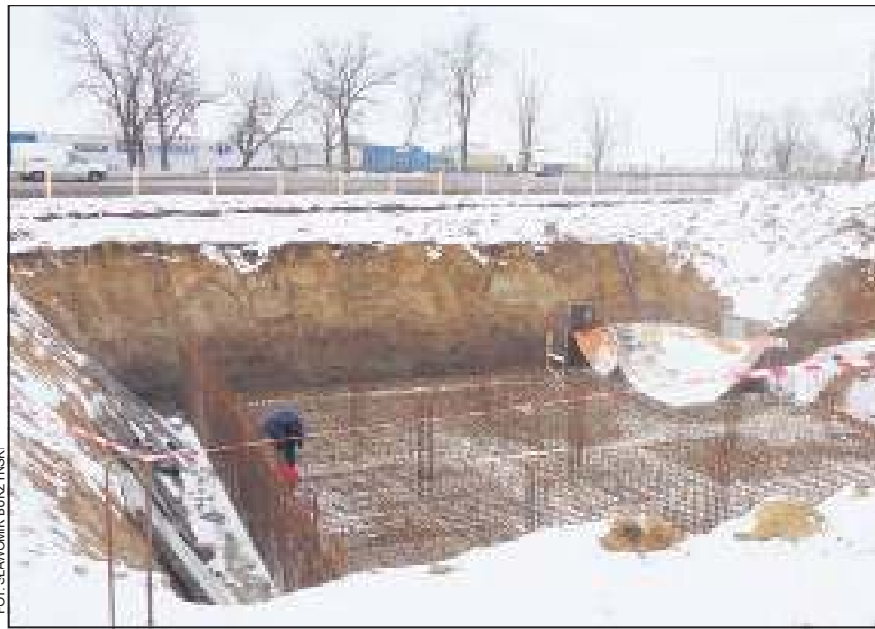
Prace ziemne pod przyszłe Tesco idą pełną parą
