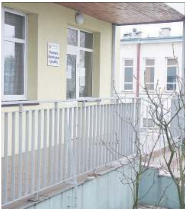
W tym miejscu będzie funkcjonować nowa przychodnia
