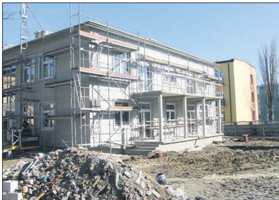
Prace trwają na zewnątrz i wewnątrz żłobka
