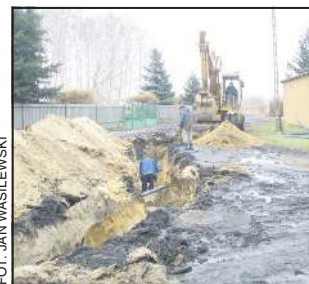
Prace przy budowie nowej kanalizacji
