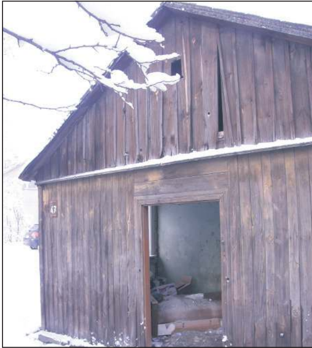
Opuszczony dom przy Wyszogrodzkiej 47
