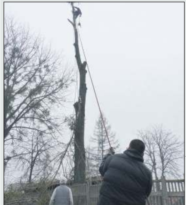
Uschnięte stare topole trzeba było ścinać od góry
