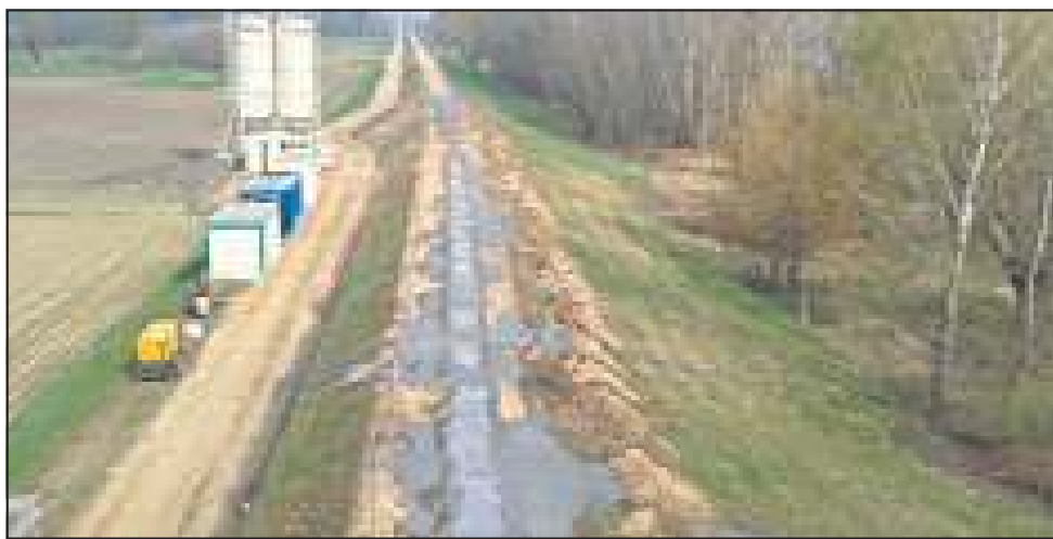
Przez dwa lata trwały prace nad odbudową wałów i urządzeń przeciwpowodziowych
