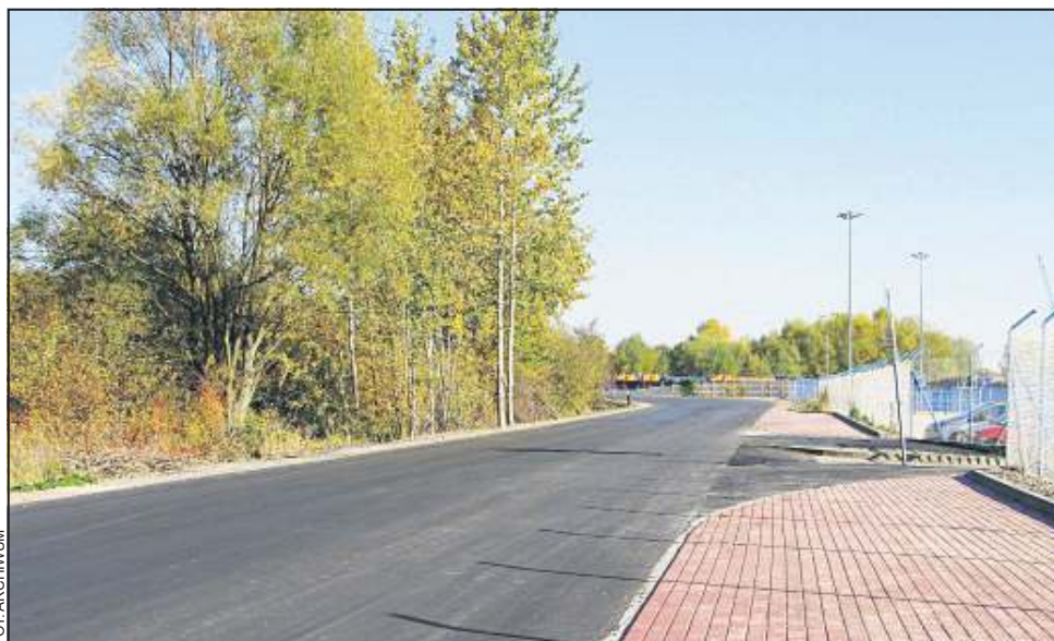
Remont ulicy Kościńskiego to wspólna inwestycja miasta i firmy Wavin
