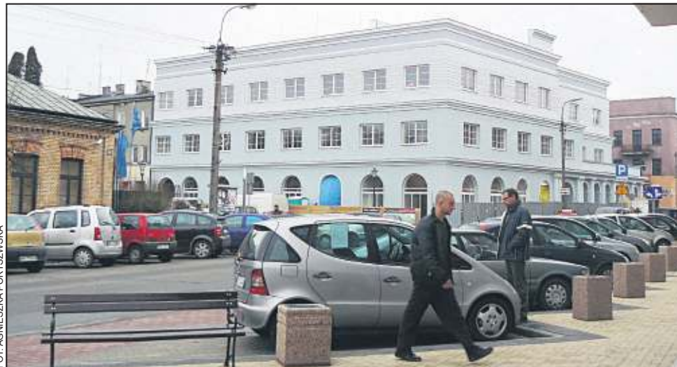
Pomimo że remont nadal trwa, kramnice już prezentują się efektownie
