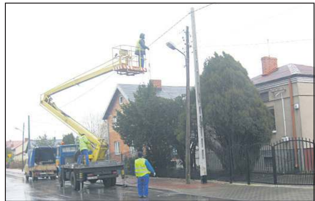
Płataninę kabli zastąpił jeden, porządnie zaizolowany, przewód
