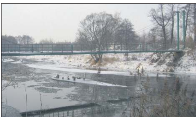
Mieszkańcy czekają na drogę do kładki
