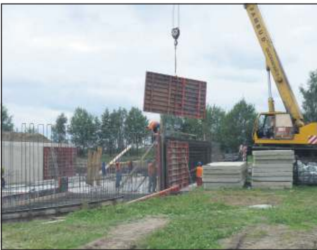
Jeszcze niedawno plac budowy oczyszczalni w Teresinie tętnił życiem
