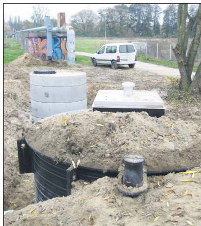
Przepompownia ścieków sprawiła wykonawcom spore problemy
