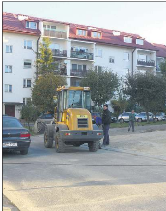
Prace celowo przeprowadzono pod koniec sezonu inwestycyjnego
